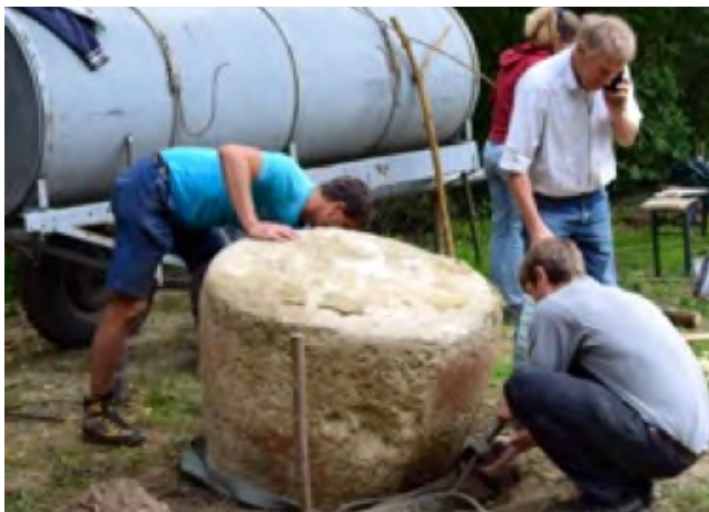
Abb. 25 Transport des ca. 200 Jahre alten Presssteins durch Hermann Schwarzl. Der Pressstein wurde an einer, vorher mittels einer tragbaren großen Wanne genau abgeschätzten und festgelegten Position, abgeladen. Die obere Erdschicht wurde abgetragen und der leicht vasenförmige Stein mit der Weitung nach oben aufgestellt. Durch Kippen und unterfüttern mit Schotter wurde er ins Lot gebracht.
