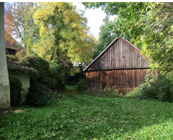
Abb. 11 Blick auf den Stadl Richtung Norden; Starnwörth, Juli 2019
