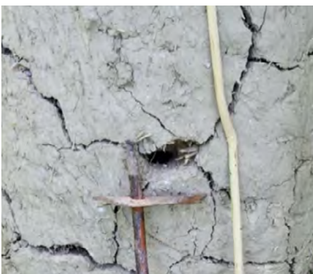
Abb. 78 -79 Bei der Mischtechnik aus Geflecht und Lehm kann es leicht passieren, dass der Lehm bei der Trocknung reißt. Durch das Entweichen des Wassers im Lehmgemisch, schwindet der Lehm wobei das Geflecht im Inneren starr bleibt. Dadurch ergeben sich Spannungen der die Lehmoberfläche nicht standhalten kann.
