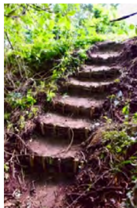
Abb. 29 Freigeräumtes Lager am Abhang der Furche, das mit eingeklopften zugespitzten Rundhölzern umgrenzt wurde. In die Stecken wurden Weidenruten eingeflochten. Am Boden sieht man die erste Fuhre Hackschnitzel verstreut, die beim Abbeilen der Äste und Stämme anfielen.
