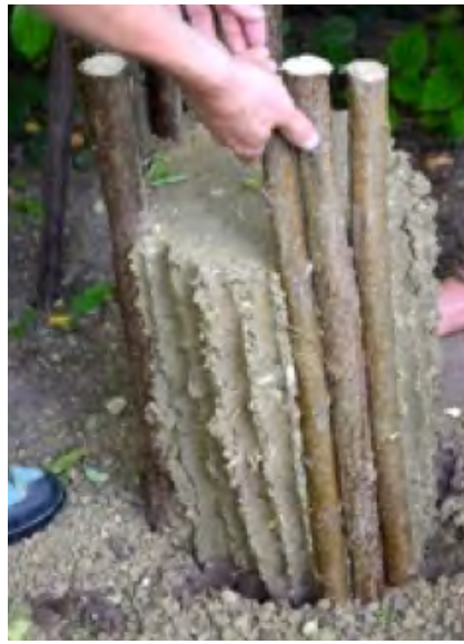
Abb. 31-33 Einklopfen der zugespitzten Rundstäbe und Sichern der Form mit Gurten. Füllen und Stampfen des Lehm-Sand-Schottergemischs in Schichten und herausziehen der Rundstäbe gleich nach getaner Arbeit.
