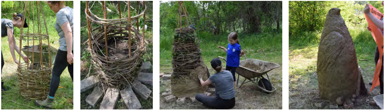
Abb 61-64: Entstehung der Wächter-Figur vor dem Torbogen. Mithilfe von einem Innengerüst aus Geflecht wurde erst die Grundform erstellt und danach mit Lehm überzogen.
