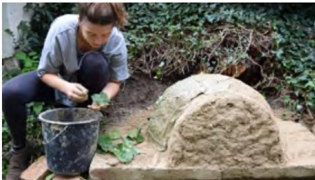
Abb. 34 Anfertigung des sphärisch-kuppelig geformten Lösssandkerns für den Lehmofen, der dann mit einer Blättertrennschicht belegt wurde und über dessen ausgestülpten Bogen, mit alten Ziegeln ein Bogen gemauert wurde. Der Kuppelbereich wurde dann mit einer ca. 10-15 cm dicken Lehmschicht (Lehm gemischt mit etwas Strohhäcksel) umbettet.
