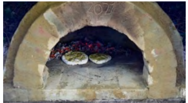
Abb. 35 zeigt den Ofen ca. 3 Wochen später nach Herauskratzen des Sandkerns. Ein erstes Feuer wurde entzündet. An der inneren Schwärzung lässt sich ablesen, dass erst ab ca. 15 cm Höhe der Rauch die innere Kuppel schwärzt (die Kuppel ist ohne Kaminöffnung). Ein erster Versuch mit Fladenbrot ist halbwegs gelungen. Der Deckel, für den die Schablone abgenommen wurde, war zu der Zeit noch nicht fertig.
