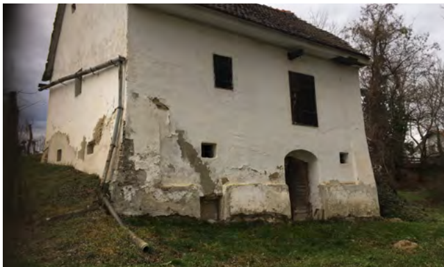
Abb.5-6 das Presshaus ist zwar baufällig, könnte aber bei sorgsamer Renovierung vielerlei Möglichkeiten zur Umnutzung bieten.
