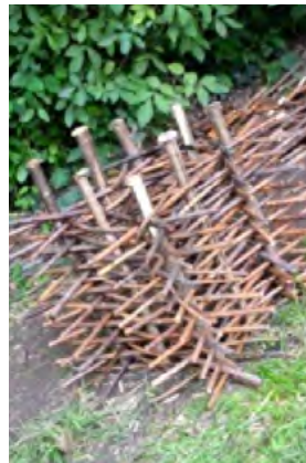
Abb. 26-28 In die Erde geklopfte, zugespitzte Haselstecken, die dann mit kurzen Weidenstäben ausgeflochten wurden.
