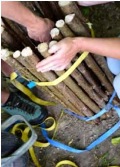
Abb. 31-33 Einklopfen der zugespitzten Rundstäbe und Sichern der Form mit Gurten. Füllen und Stampfen des Lehm-Sand-Schottergemischs in Schichten und herausziehen der Rundstäbe gleich nach getaner Arbeit.
