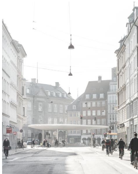
COBE und Gottlieb Paludan Architects: Nørreport Station, Kopenhagen/Dänemark, 2015 © Foto: Rasmus Hjortshøj – COAST
