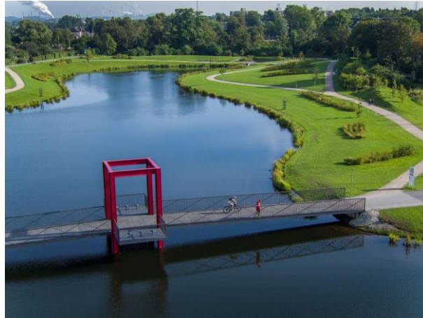
Radschnellweg Ruhr RS1, Niederfeldsee in Essen, Brücke: Ahlbrecht Baukunst, Essen © Opterix, Johannes Kassenberg
