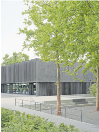
DER NEUBAU ist in den Hang platziert. Die Betonlamellen schirmen die Innenräume ab und versorgen sie gleichzeitig mit Tageslicht.
