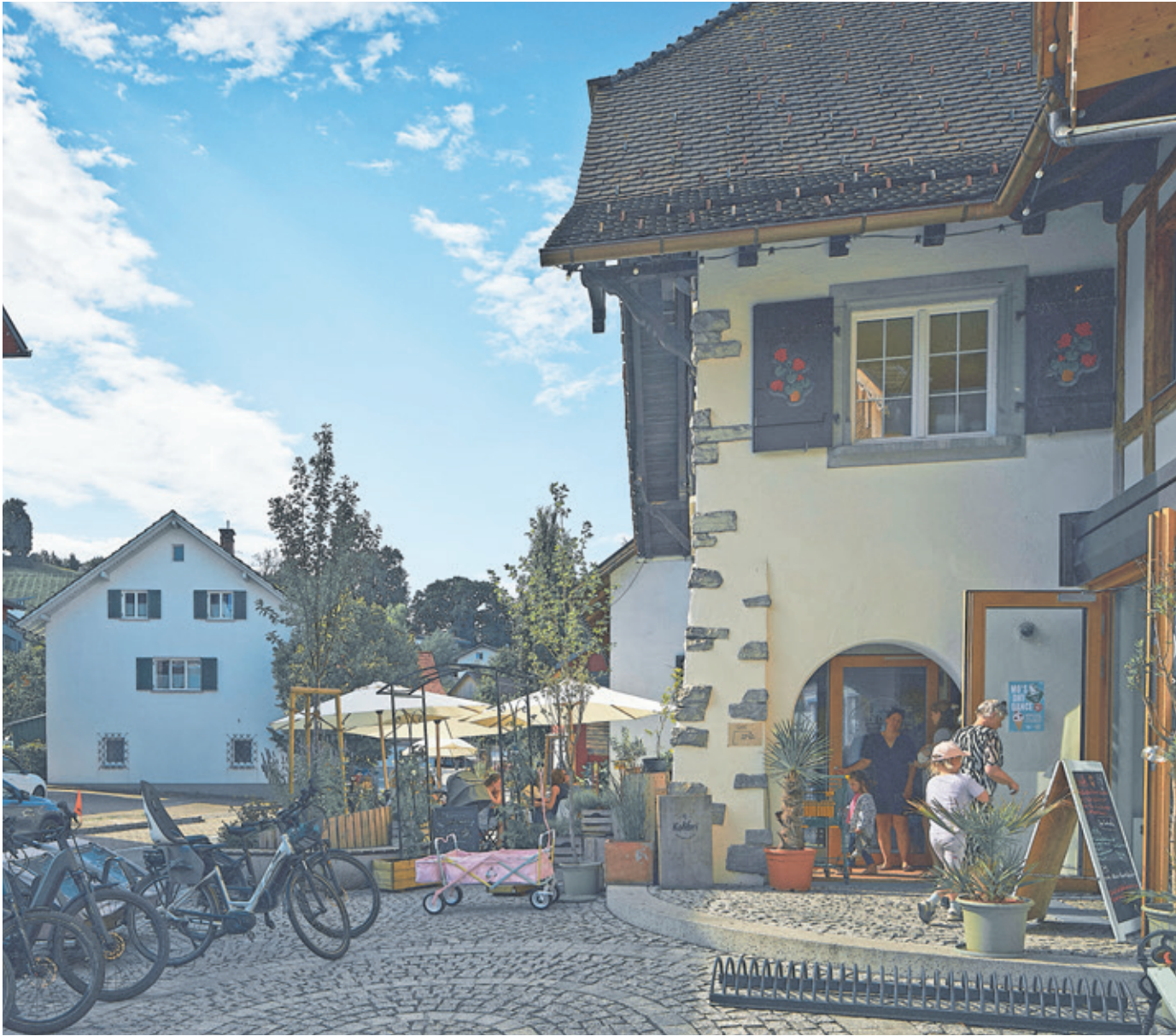
Die sanierten Gebäude von Kolibri und Dreierlei tragen mit ihren frequentierten Erdgeschosszonen wesentlich zur Belebung des Zentrums bei.
