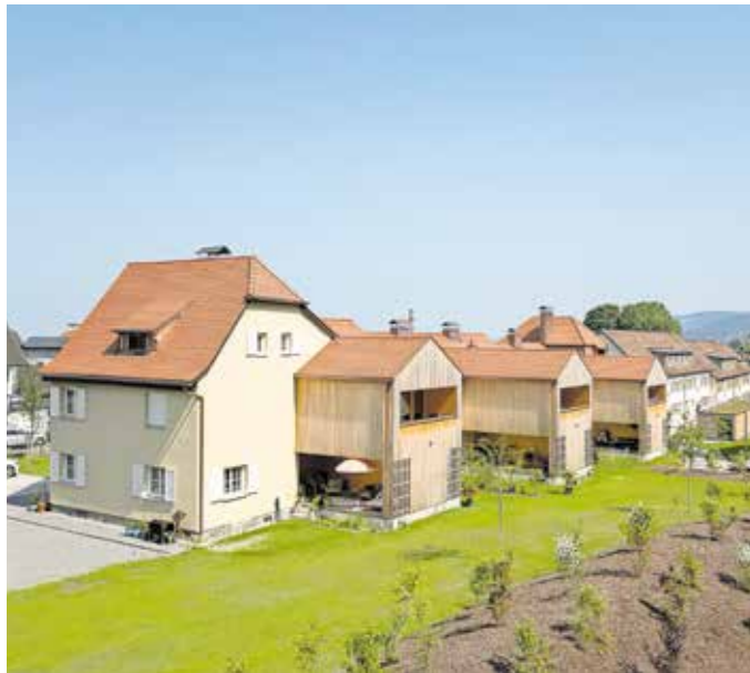
Die Zubauten sind abgeleitet von einem bereits zuvor existierenden Schopf. Dieser ist nun kein Geräteschuppen mehr sondern bietet eine neue willkommene Erweiterung mit Freiraumbezug.
