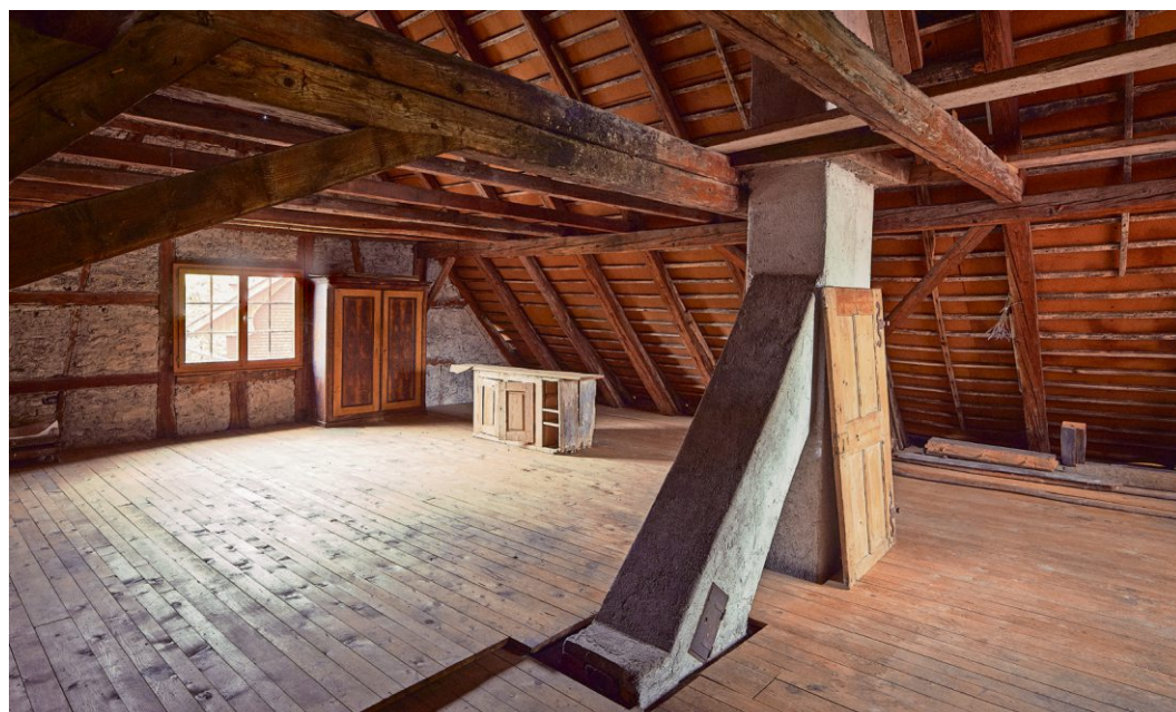
In den Dachgeschoßen ist Fachwerk erhalten, andere Teile des Hauses bestehen aus Natursteinmauerwerk.
