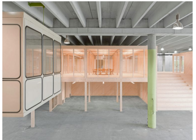
PRAGMATISCH UND GUT. In die offene Tragstruktur wurden neue Räume aus Holz eingestellt.
