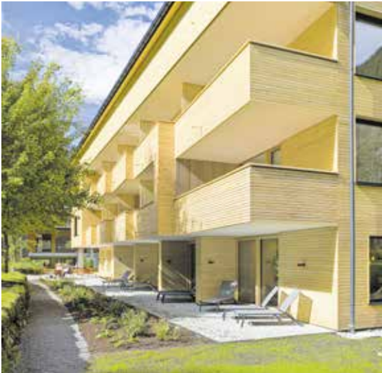
NEUES HOLZ Das Gartenhaus hat die Architekturwerkstatt Dworzak-Grabher sehr umfassend saniert.
