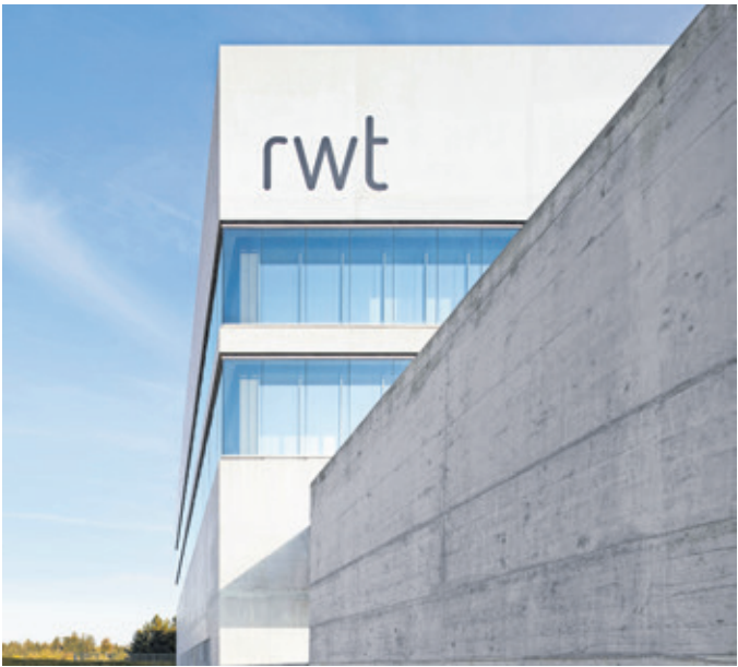
Auf dem massiven Gebäudesockel, der die Einstellhallen für den Fuhrpark, Lagerflächen und Werkstätten aufnimmt, sitzen die zwei rundum verglasten Büroetagen.
