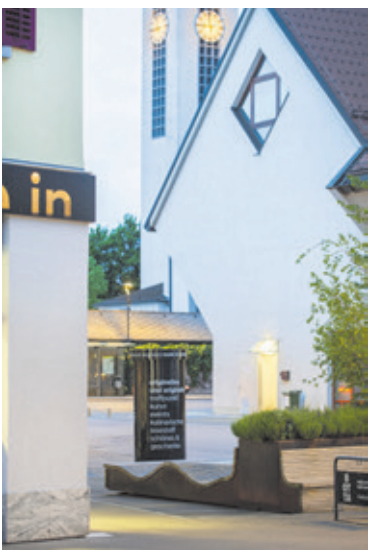
DER WEISSE BAU mit dem rautenförmigen Fenster ist die Rückseite des Reichshofsals.
