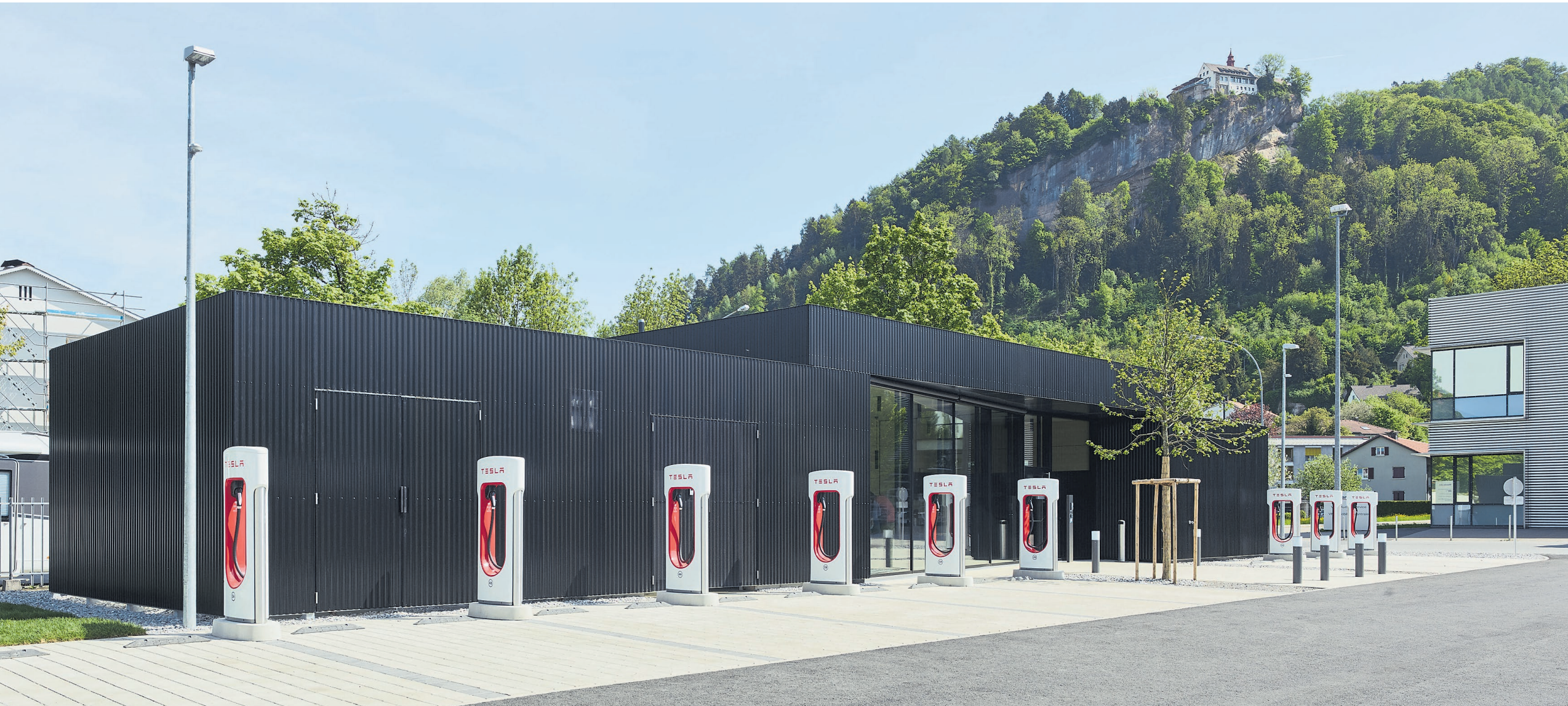
PROTOTYPISCHE TANKSTELLE DER ZUKUNFT Die E-Mobilitäts-lounge in Bregenz von den Architekten reitbruggerGAU.
