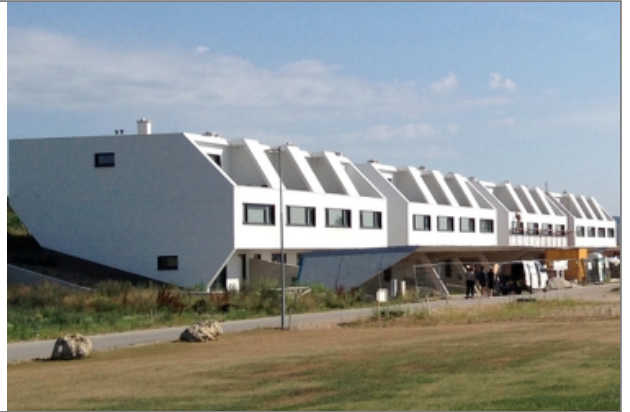
Reihenhausanlage Kittsee, © ad2 architekten
