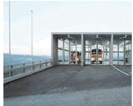
01_AT08_OÖ: Freiwillige Feuerwehr Pöstlingberg, Architektur: archinauten Foto: Dietmar Tollerian
