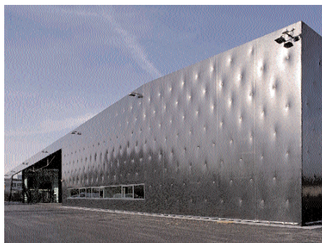
02_AT08_OÖ: Betriebswerkstätte Ansfelden, Architektur: caramel architekten, Foto: Herta Hurnaus
