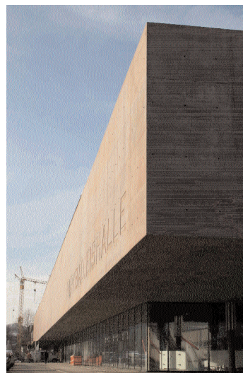
03_AT08_OÖ: Parkbad Linz, Eishalle, Architektur: Riepl Riepl Architekten, Foto: Josef Pausch
