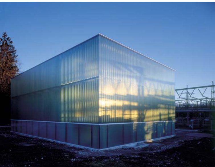
Umspannwerk Vorarlberger Kraftwerke AG in Bregenz, Dietrich I Untertrifaller Architekten Foto: © Ignacio Martinez
