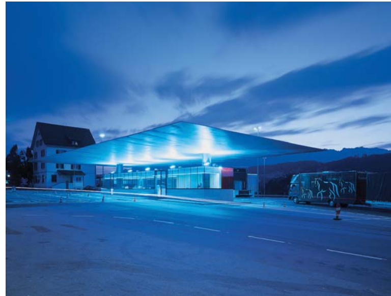
Grenze Feldkirch Tisis/Schaan, Inselgebäude mit Überdachung; Architektur: aix architects Foto: © Ignacio Martinez
