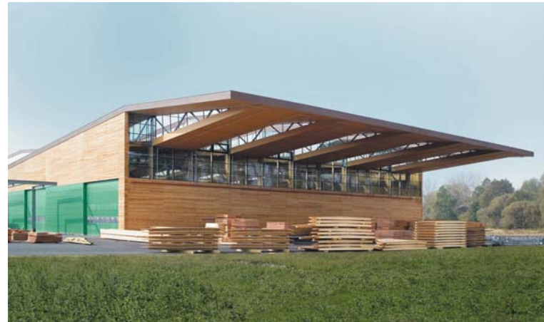
Produktionshalle Obermayr Holzkonstruktionen; Architektur: f2architekten Foto: © Obermayr Holzkonstruktionen GmbH
