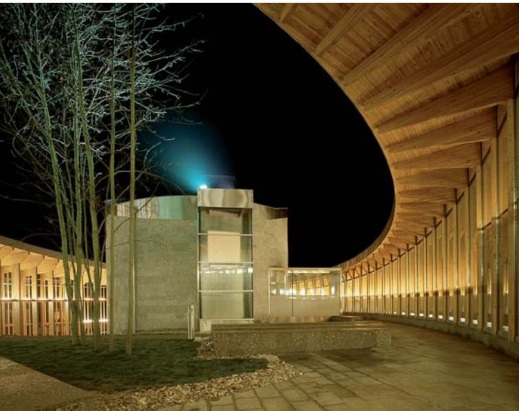
Katholische Pfarrkirche Gallsbach; Architektur: Architekten Beneder/Fischer Foto: © Margherita Spiluttini
