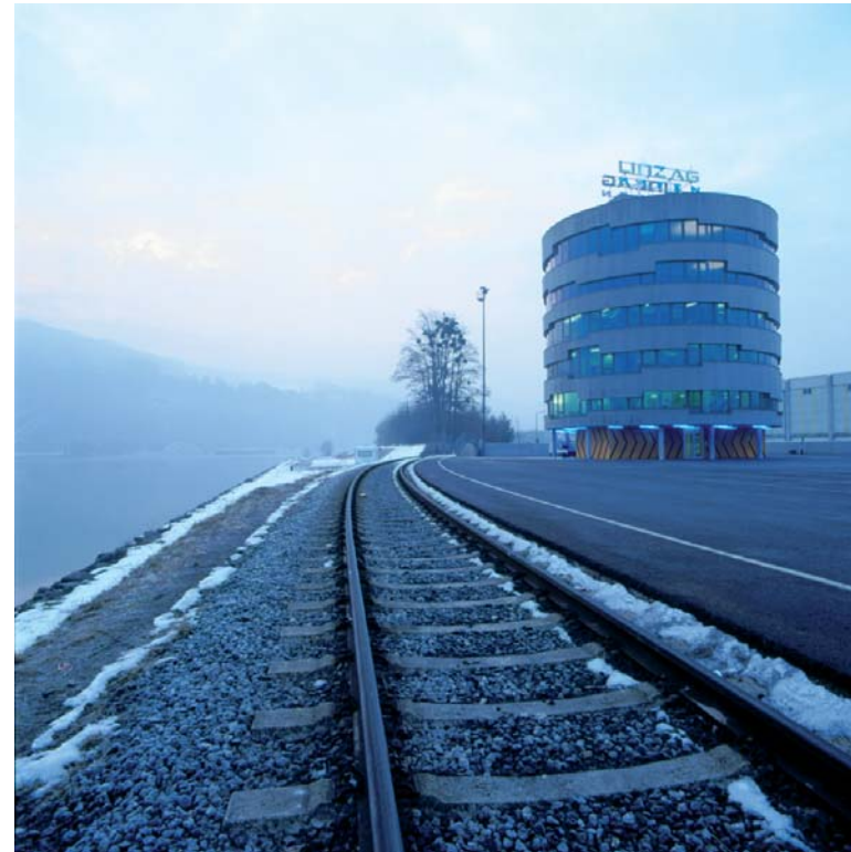
Bürogebäude der Linz AG; Architektur: x architekten Foto: © Dietmar Tollerian
