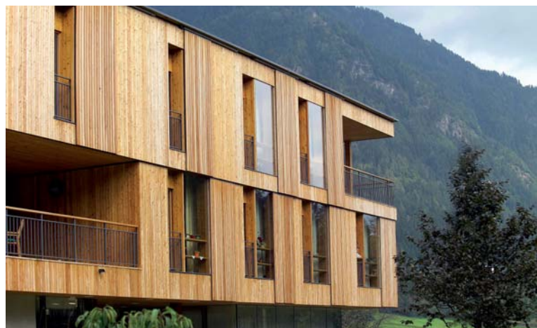
Altenwohnheim Steinfeld; Architektur: Arch. Dietger Wissounig Foto: © proHolz/Theny
