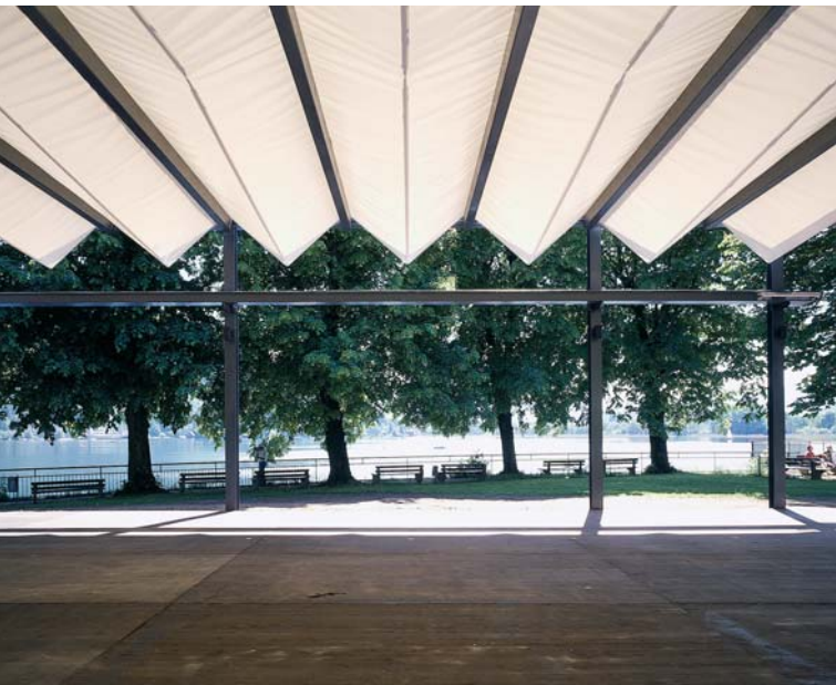
Zeltkonstruktion Annenheim; Architektur: spado architects Foto: © Gisela Erlacher
