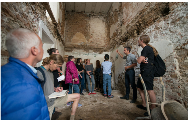
Baustelle Mia; Foto: Petra Moser
