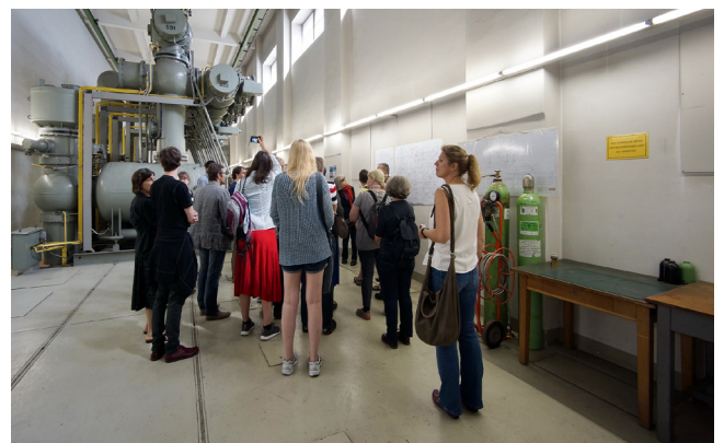
Architektur und Energie Bustour, Umspannwerk Favoriten
