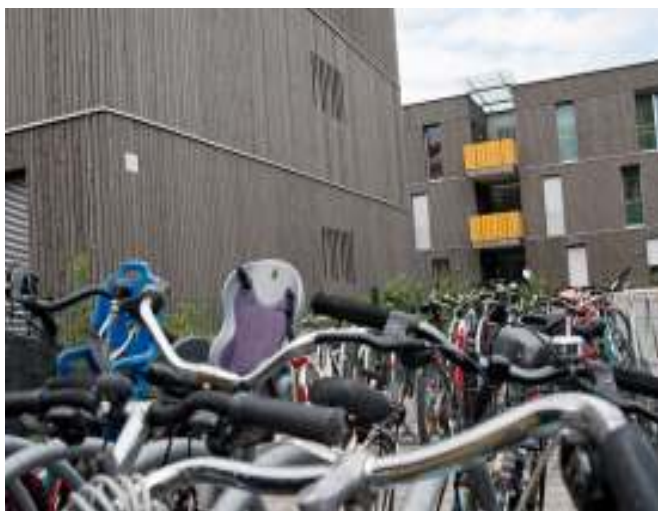
Passivwohnanlage Samer Mösl, Foto: Herta Hurnans
