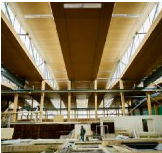
Elementfertigungshalle Obermayr, Foto: Lukas Schaller
