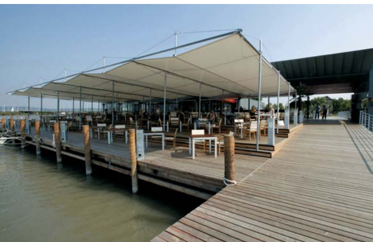
Mole West, Neusiedl am See; Architektur: Halbritter & Halbritter, Halbritter und Hillerbrand Foto: © Harry Mannsberger
