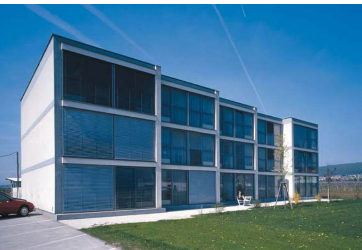
Reihenhausanlage Winzerweg, Eisenstadt; Architektur: Fritz Brandlhofer Foto: © Manfred Seidl
